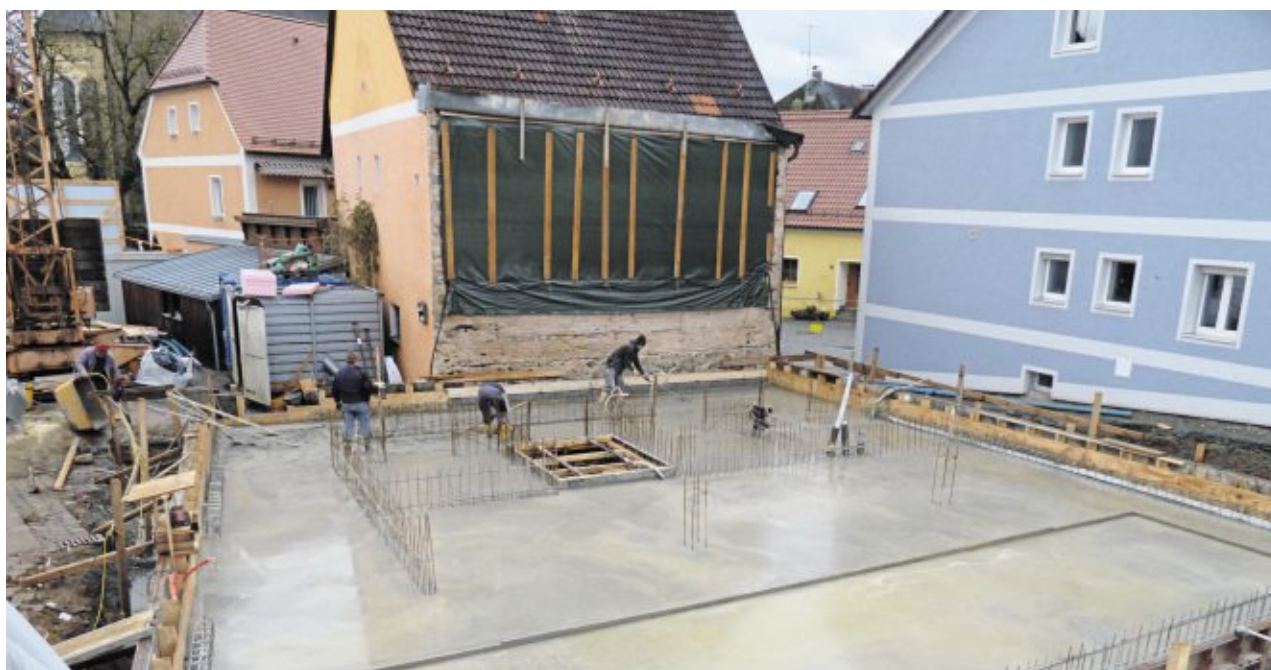
Während die Sohle für das künftige Stadtarchiv im Mühlweg bereits am 7. Dezember betoniert wurde, gab es in den zwei weiteren Adventswochen noch einiges zu tun.
